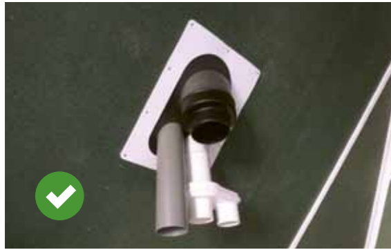
De dakdoorvoeren luchtdicht afgewerkt met een manchet.
