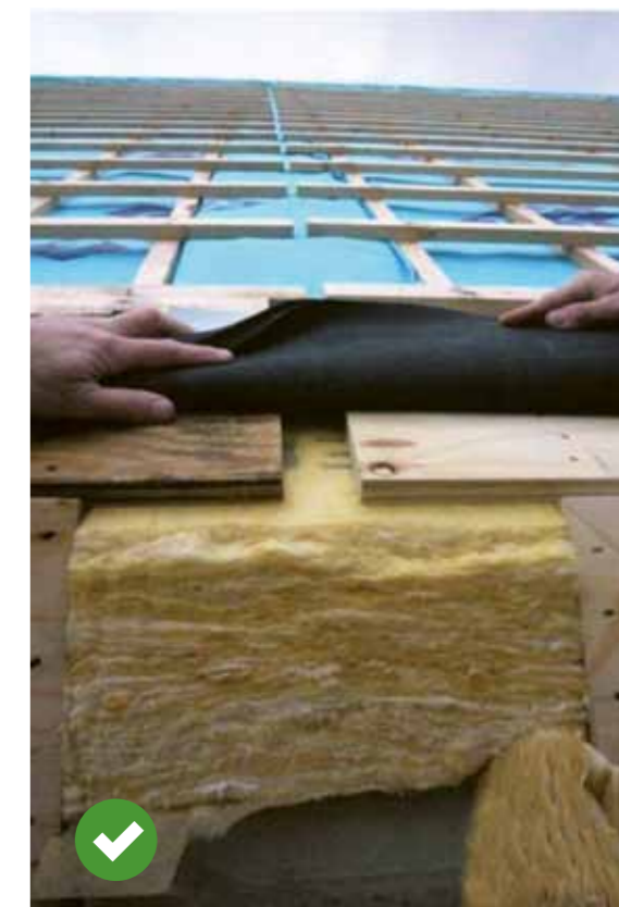
Goed geïsoleerd ter plekke van de woningscheidende wand
