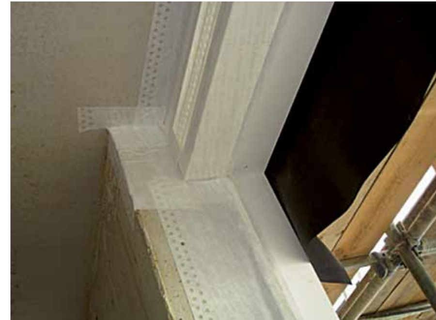
Kozijn aan de binnenzijde luchtdicht afgeplakt.
