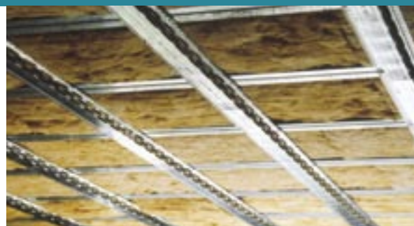
56. Geluidsarme veerregels als akoestische ontkoppelde bevestiging van het plafond aan de vloer (Profilhaus, Ettlingen).
