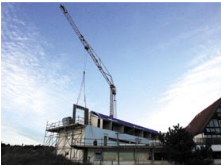
8. Optop jongerenhostel Stayokay (Terschelling, 2001). Vanwege het lage toelbare gewicht kon deze uitbreiding uitsluitend met staalframebouw.
