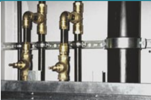
70. Geluidarme bevestiging van leidingen in een metalstudwand.
