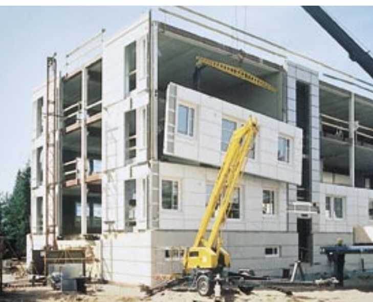
47. Montage van geprefabriceerde elementen (Rautaruukki Oyj, Finland).
