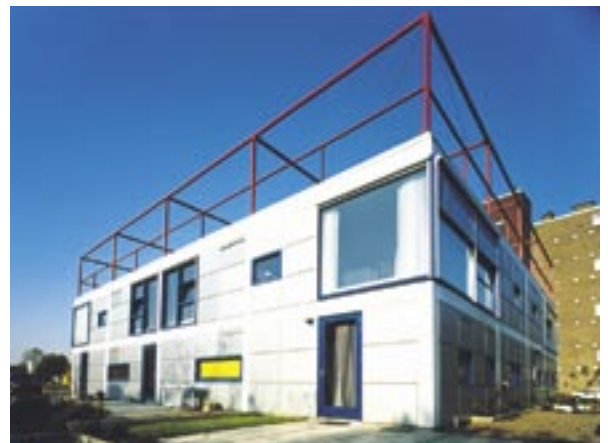
17. Woningen met een hoofddraagconstructie van staalframebouw (Dedemsvaartweg, Den Haag).
